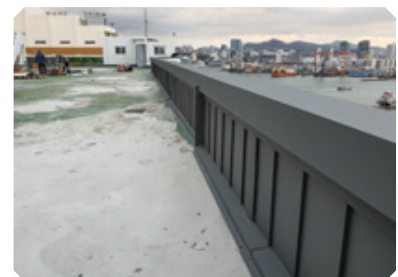
난간 두겹 및 내벽 징크 작업
