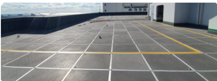
방수패널 설치 작업
