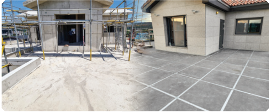
액체 방수 시공 현장
