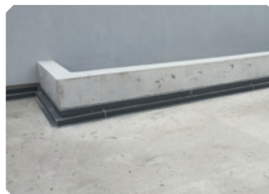
하부커팅 및 마감앵글 작업
