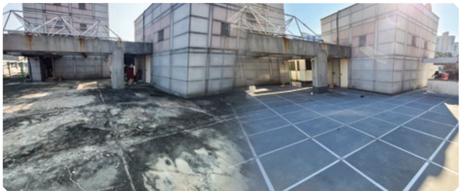
도막 방수 시공 현장
